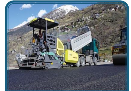
V. Colocación de Mezcla Asfáltica en Caliente
