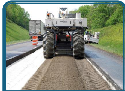
II. Estabilización de la Subbase
