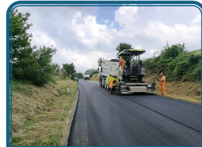
IV. Colocación del Material reciclado
